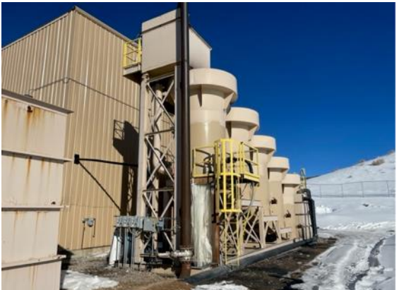
ADR Exterior Columns
