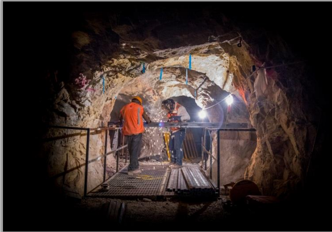
Las Chispas Underground Rehabilitation
